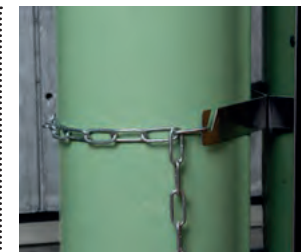
Bombola di gas compresso fissata
